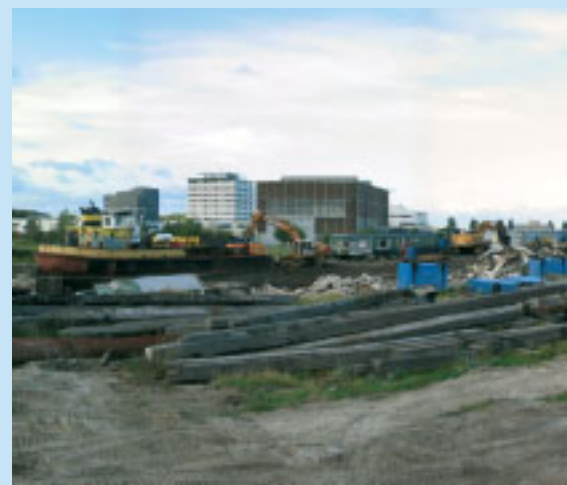
Terrein oude energiecentrale, Amsterdam Noord
